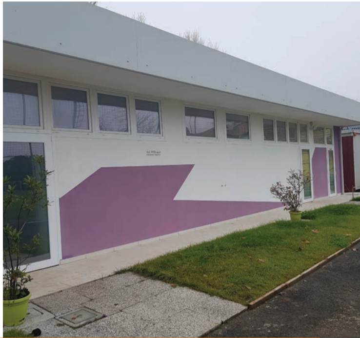
GLI SPOGLIATOI DEL CAMPO SPORTIVO DI GRANAROLO
